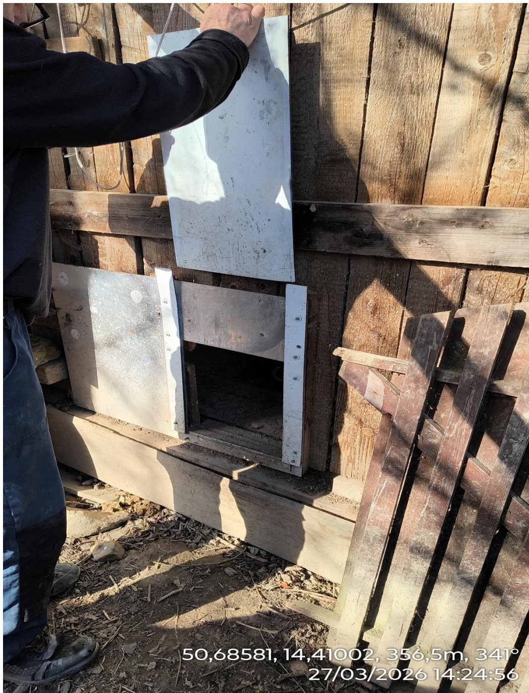
snímek č. 4 - průřez z kůlny do výběhu s vysunovací deskou
