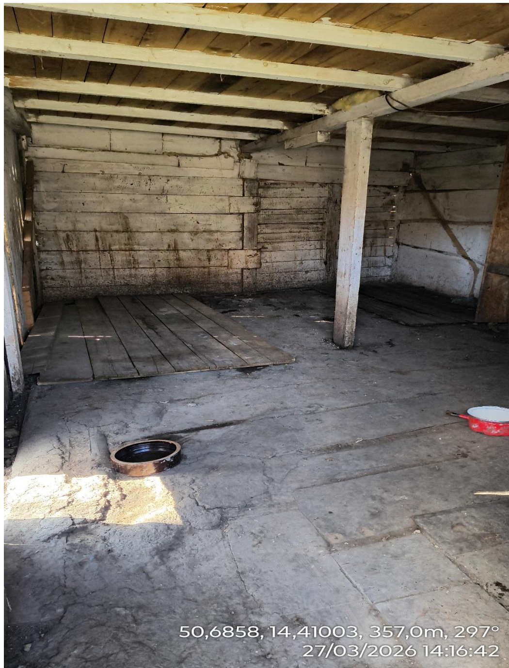
snímek č. 6 – vnitřní prostor kůlny
