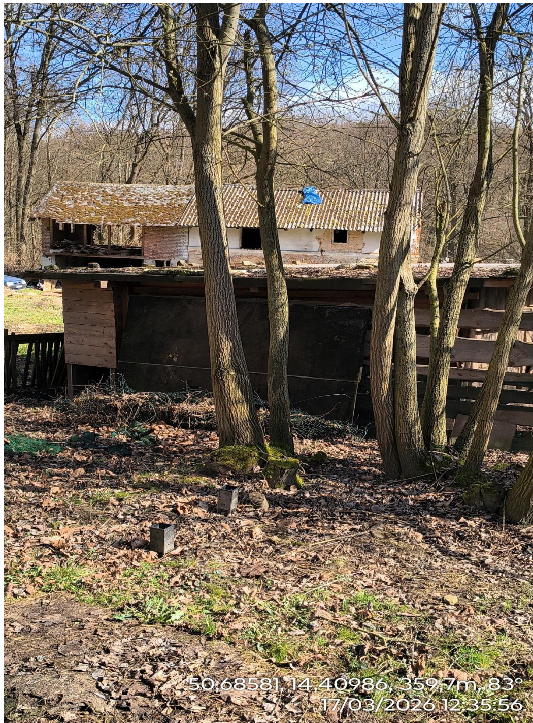
Snímek č. 1 - zadní strana dřevěné kůlny (pohled od silnice směr z Jezvé do Heřmanic)
