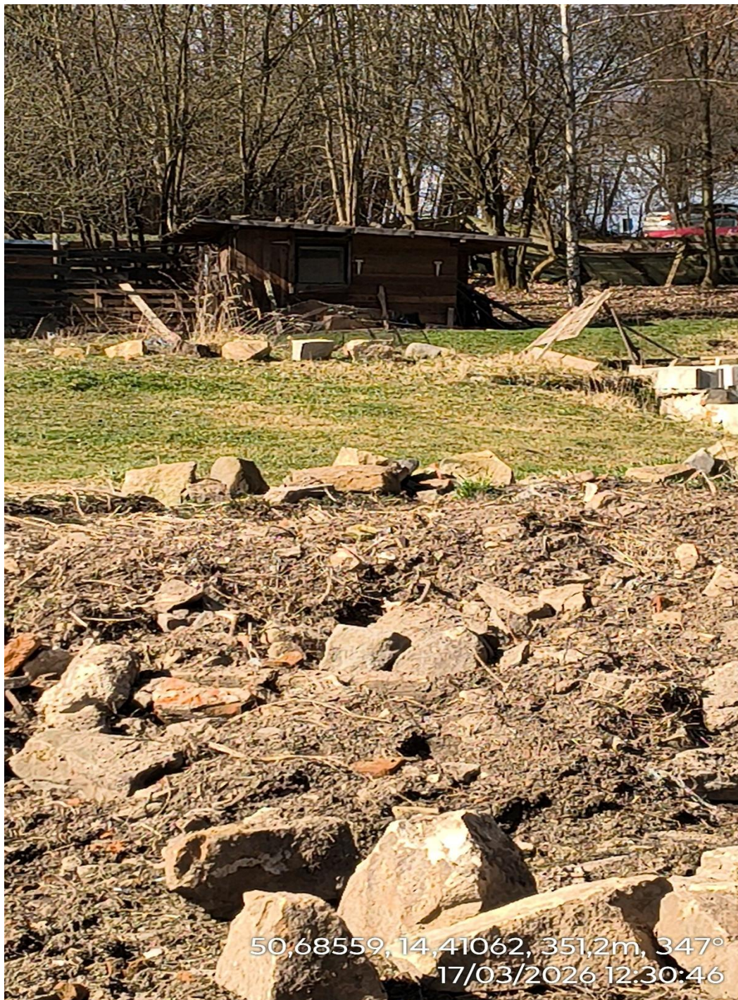
snímek č. 3 – přední strana dřevěné kůlny s oknem a vstupem dovnitř
