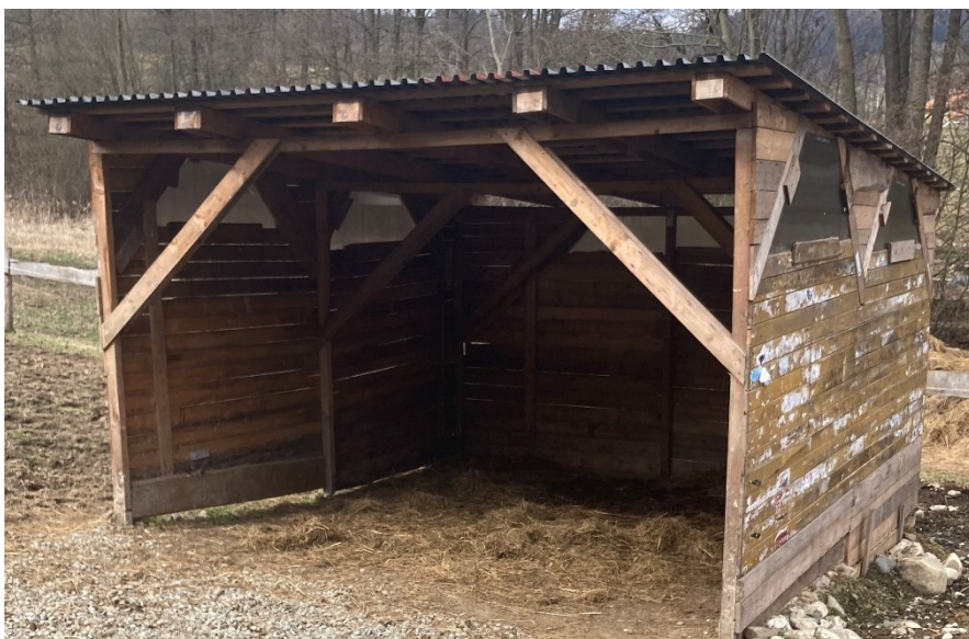
Fotografie č. 5 – přístřešek
