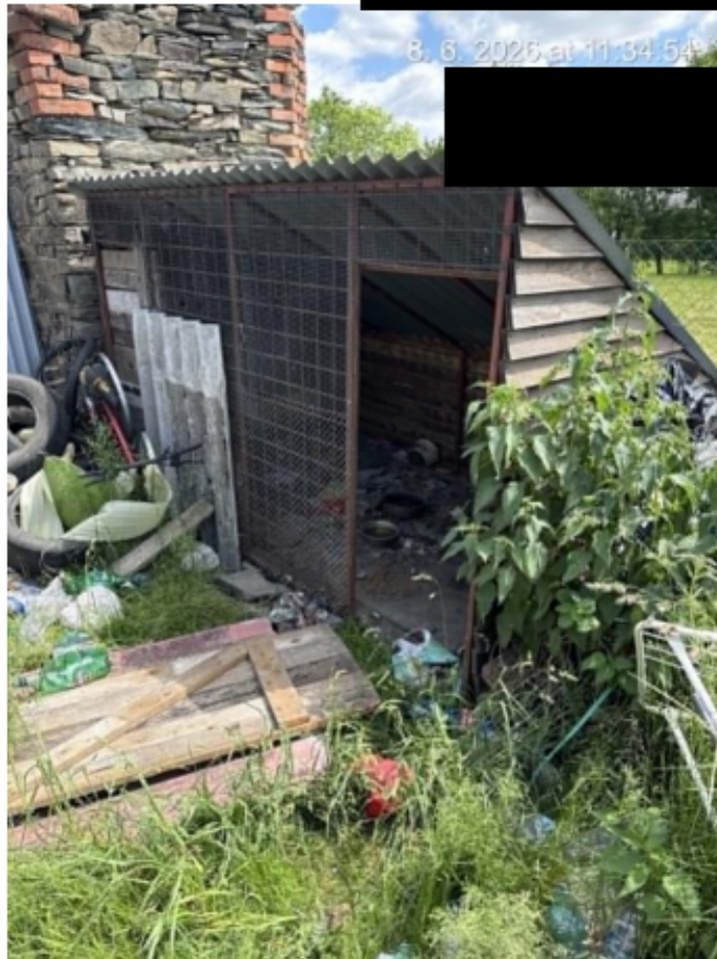
Foto č. 5 – kotec pro psa jménem Kelly, spadená dvířka, odpady
