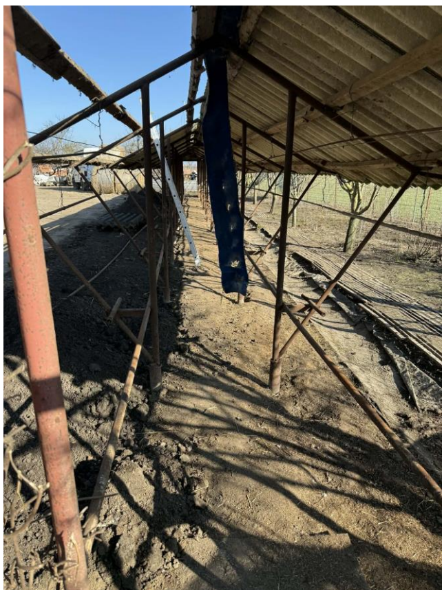
Foto č. 14 – přístřešek po vyklizení klecí
